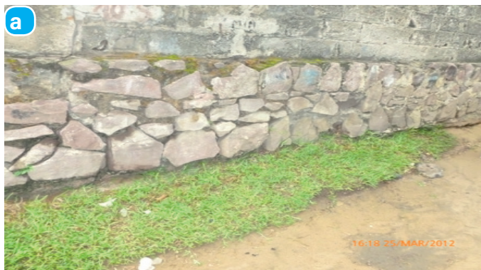
Figure 4| Effet du déchaussement (a) Déchaussement d'une maison à Livulu (Photo Fils Makanzu, CRGM_Mars 2012); (b) Déchaussement d'un manguiier à Djelo Binza (Photo Fils Makanzu, CRGM_Avril 2011)
